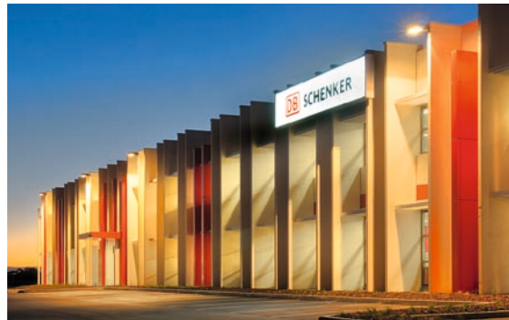
Hochmodern – und grün: Das DB Schenker Warehouse am Flughafen Melbourne
